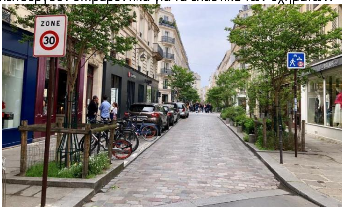
Αλλαγή υφής στο σύνολο του οδοστρώματος
