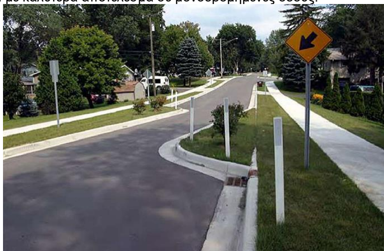
Παράδειγμα μεταβολών του άξονα της οδούς
