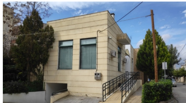
Figure 4.64 Γενική άποψη του κτηρίου Β ΚΑΠΗ Δήμου Αγίων Αναργύρων.
