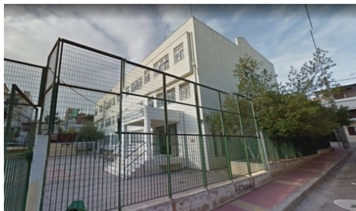
Figure 4.34 Γενική άποψη του κτηρίου 2 ου Γυμνασίου
