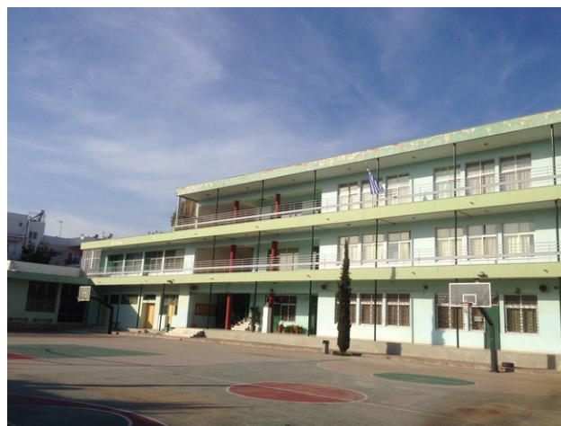
Figure 4.43 Γενική άποψη του κτηρίου 1 ου Λυκείου Αγίων Αναργύρων.
