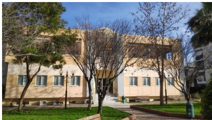
Figure 4.66 Γενική άποψη του κτηρίου Δ ΚΑΠΗ του Δήμου Αγίων Αναργύρων.
