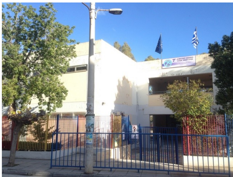
Figure 4.31 Γενική άποψη του 7 ου Δημοτικού σχολείου Αγίων Αναργύρων.
