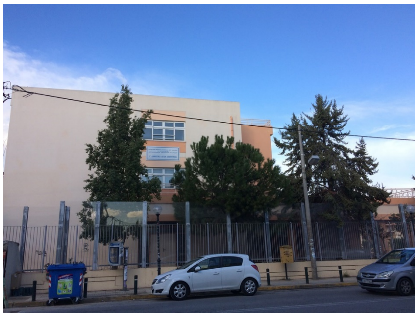
Figure 4.15 Γενική άποψη του κτηρίου 1 ου Δημοτικού σχολείου Αγίων Αναργύρων.
