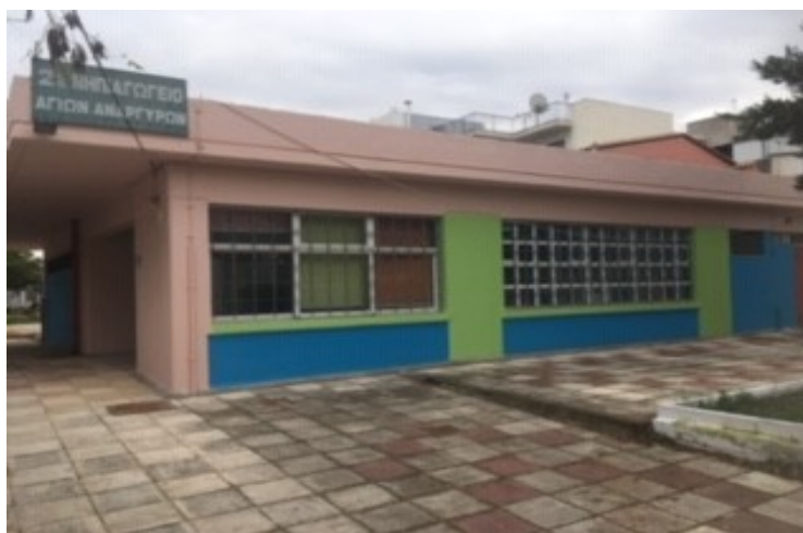
Figure 4.2 Γενική άποψη του κτηρίου του 2 ου Νηπιαγωγείου Αγίων Αναργύρων.
