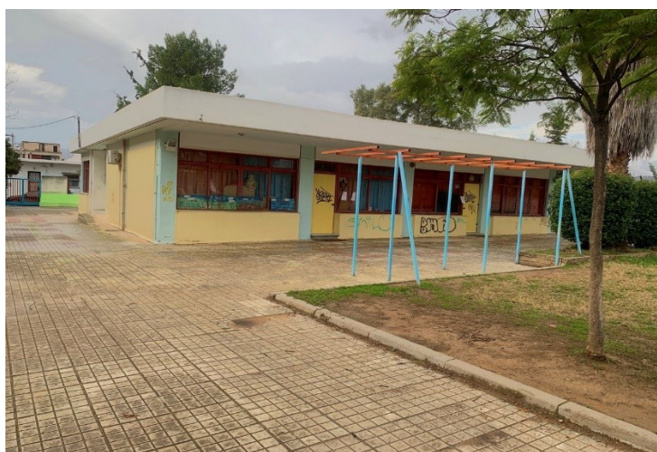
Figure 4.5 Γενική άποψη του κτηρίου του 3 ου Νηπιαγωγείου Αγίων Αναργύρων.
