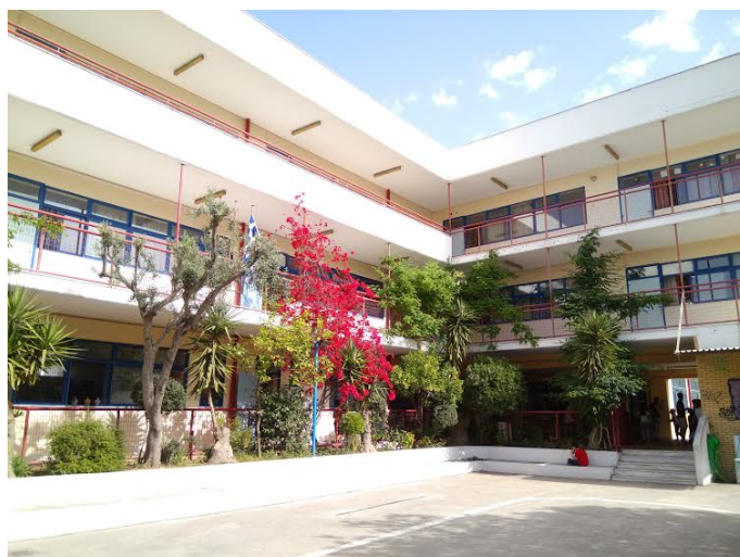
Figure 4.24 Γενική άποψη του 4 ου Δημοτικού σχολείου Αγίων Αναργύρων.
