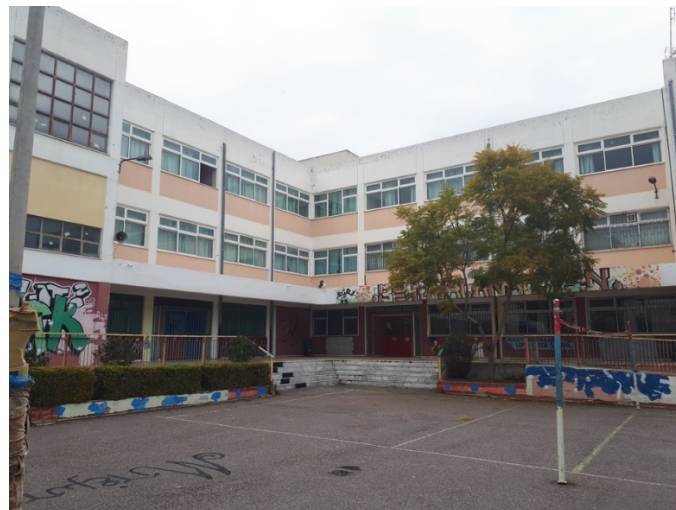
Figure 4.49 Γενική άποψη του κτηρίου 3 ου Λυκείου Αγίων Αναργύρων.
