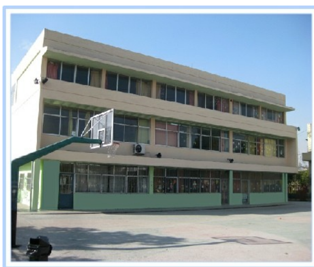
Figure 4.29 Γενική άποψη του κτηρίου 6 ου Δημοτικού σχολείου Αγίων Αναργύρων.
