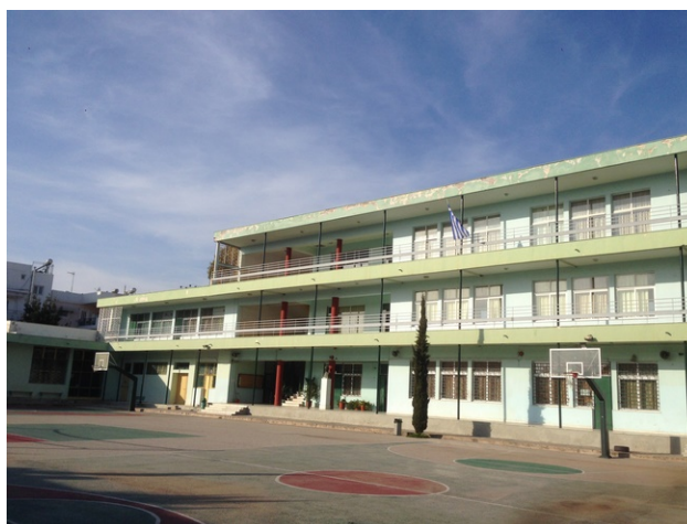
Figure 4.8 Γενική άποψη του κτηρίου 1 ου Λυκείου Αγίων Αναργύρων.
