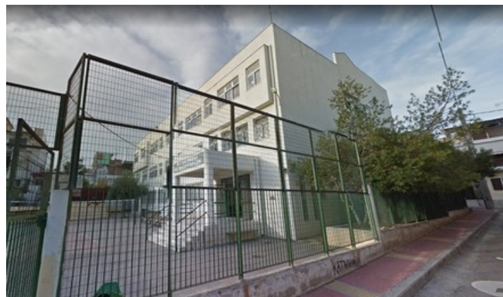
Figure 4.2 Γενική άποψη του κτηρίου 2 ου Γυμνασίου
