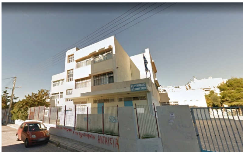
Figure 4.40 Γενική άποψη του κτηρίου 4 ου Γυμνασίου Αγ. Αναργύρων.
