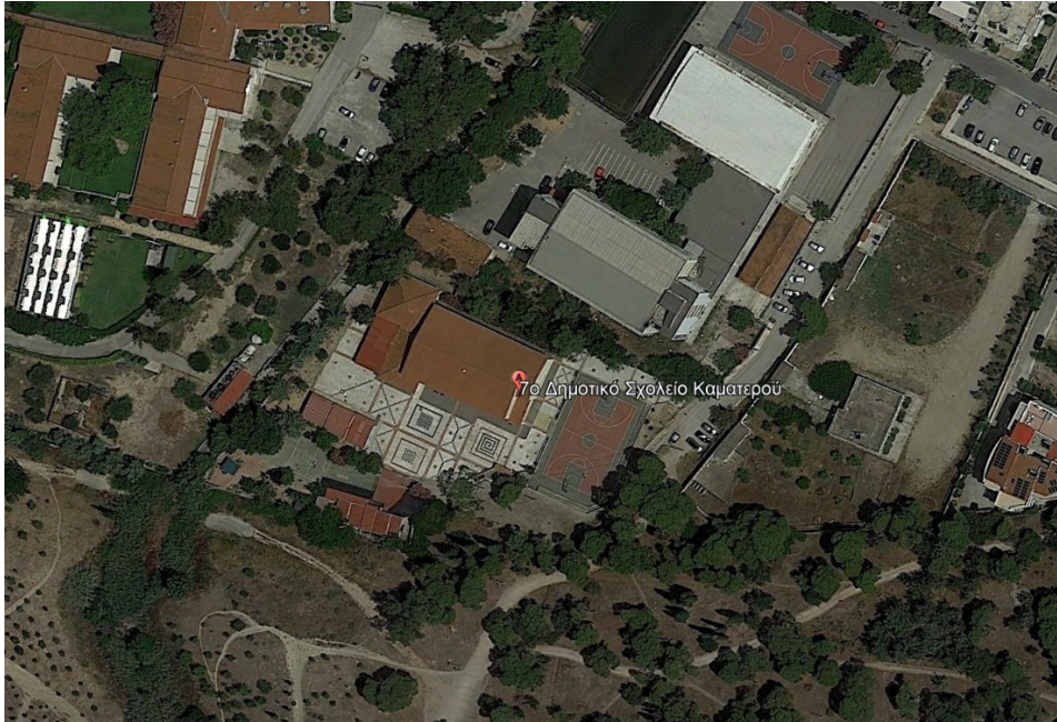
Εικόνα 2-2 Αεροφωτογραφία 7 ου Δημοτικού Καματερού
