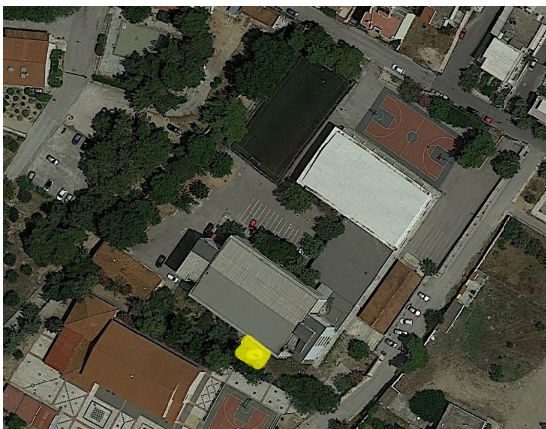
Εικόνα 3-2 ενδεικτική θέση Αντλιών Θερμότητας
